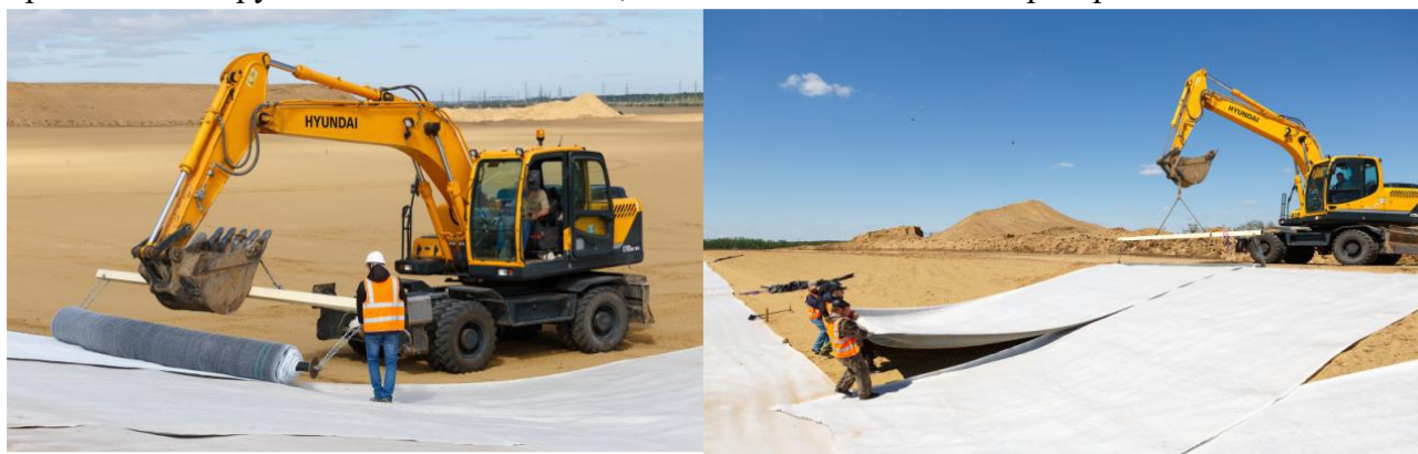
Рисунок 5 – Укладка бентонитового мата
