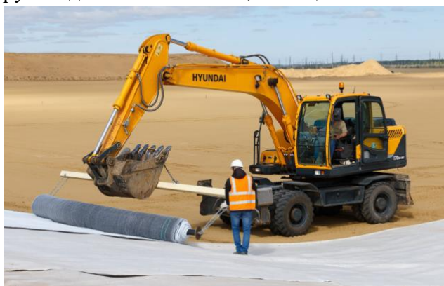
Рис. 5 – Укладка бентонитового мата
