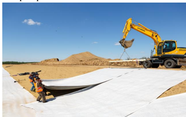
Рис. 5 – Укладка бентонитового мата
