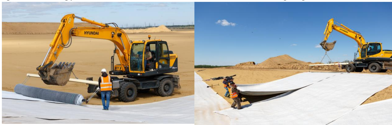
На горизонтальные поверхности маты укладываются с продольной величиной нахлестки не менее 15 см (от зеленой полосы на тканом материале) и поперечной - не менее 30 см. Поперечные стыки смежных полотнищ должны быть смещены относительно друг друга не менее чем на 30 см. Маты укладываются только в одном направлении. Перекрестная укладка полотнищ в смежных слоях не допускается. На откосах места нахлестов по ширине полотна должны быть выполнены таким образом, чтобы верхний рулон перекрывал нижний.
